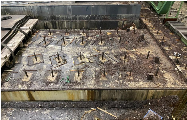
+ Vorher: Fundament nach Entnahme der Maschine
