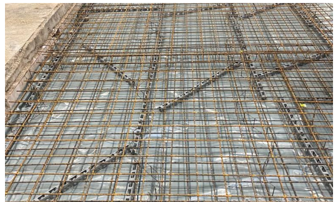
+ Fundamentinstandsetzung: Armierung vor dem Betonieren
