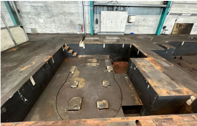
+ Vorher: Fundament nach Entnahme der Maschine
