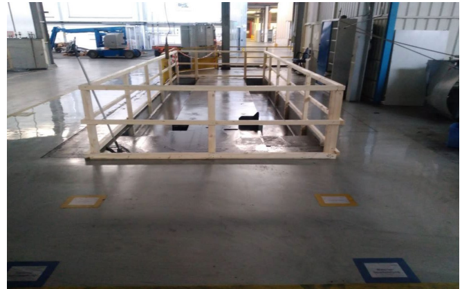
+ Nachher: gereinigtes Fundament bei der Abnahme
