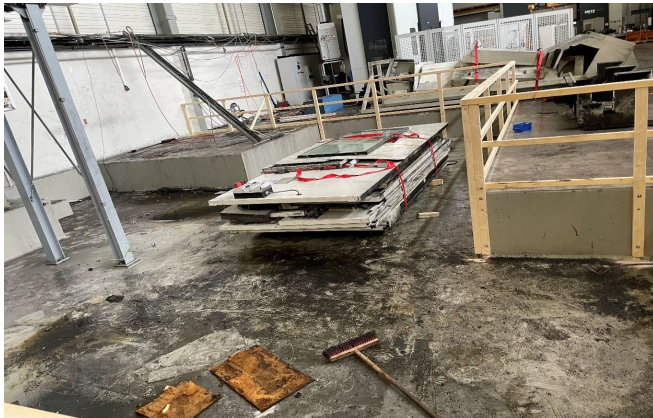
+ Vorher: Fundament nach Entnahme der Maschine
